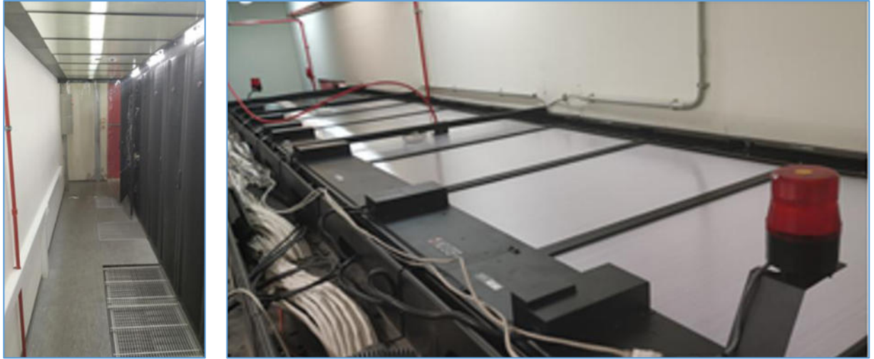
Κλειστή ζώνη ψυχρού αέρα (CACS) Κέντρου Δεδομένων Πανεπιστήμιου Κρήτης
